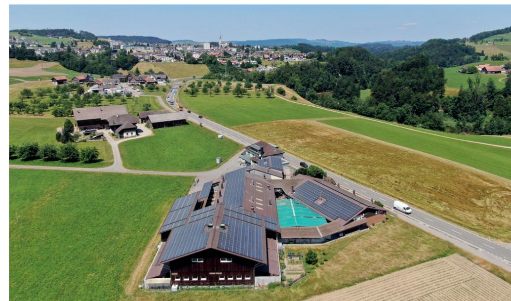
Über 1200 Quadratmeter und mehrere Dächer erstreckt sich die Photovoltaikanlage des Käserei- und Mastbetriebs in Bazenheid.
