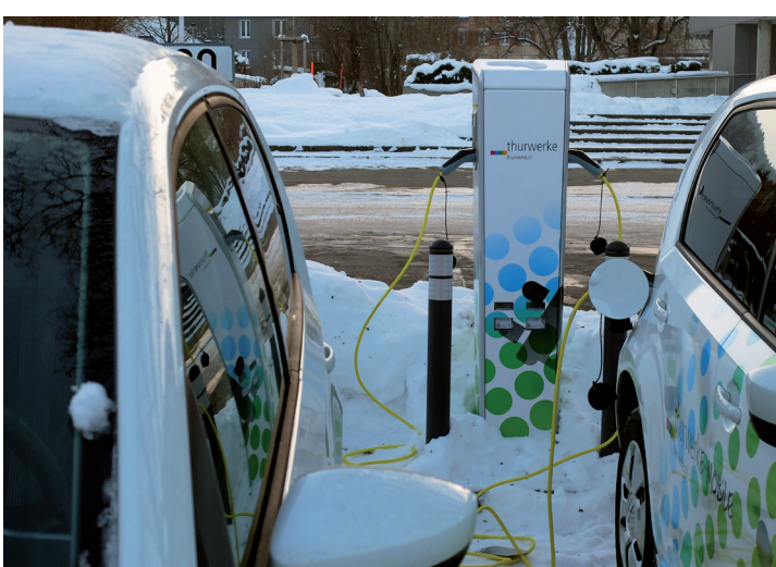
Die neue Ladestation vor dem Gemeindehaus.
