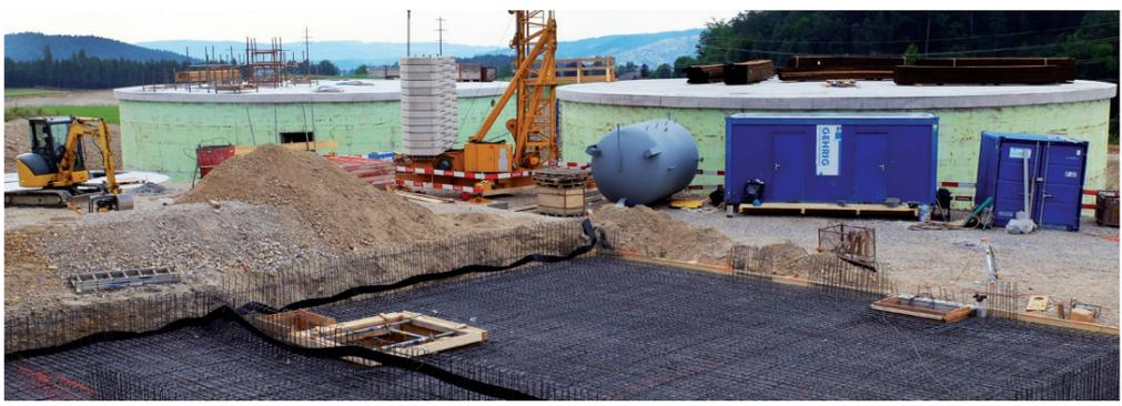
Das Herzstück der Biogasanlage, die beiden grünen runden Fermenter, sind bereits im Rohbau erstellt.
