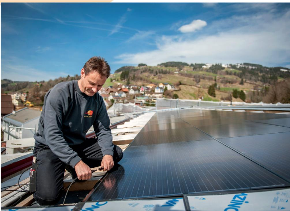
Hansjörg Roth verbindet die Module der Photovoltaikanlage auf dem Dach der neuen Raiffeisenbank in Nesslau.
