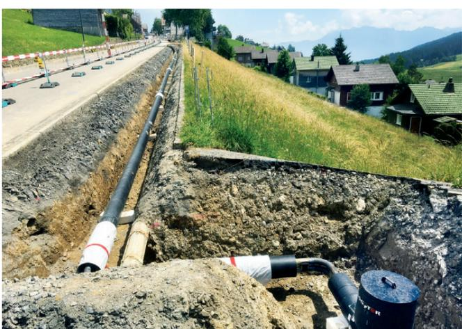
Bauarbeiten für die Erweiterung des Fernwärmenetzes Richtung Lisighaus (Bild: Urs Zwingli, Calorex)
