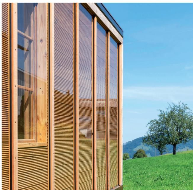
Wesentlicher Bestandteil des Gebäudekonzepts bildet die Lucido®-Modulfassade: Spezielle Holz-Lamellen wandeln Licht in Wärmeenergie um.
