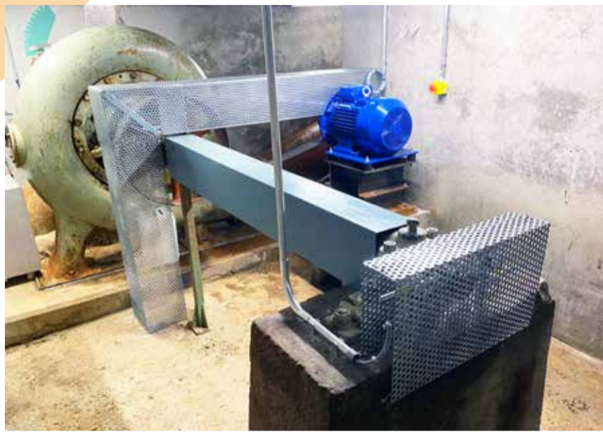
Neben der Erneuerung der Steuerung gehörten Massnahmen zur Sicherheit zum ersten Schritt der Reaktivierung des Wasserkraftwerks.
