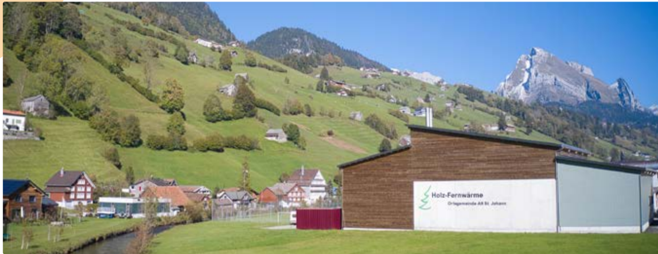
Der Wärmeverbund in Alt St. Johann beliefert 68 Liegenschaften mit nachhaltiger Energie.
