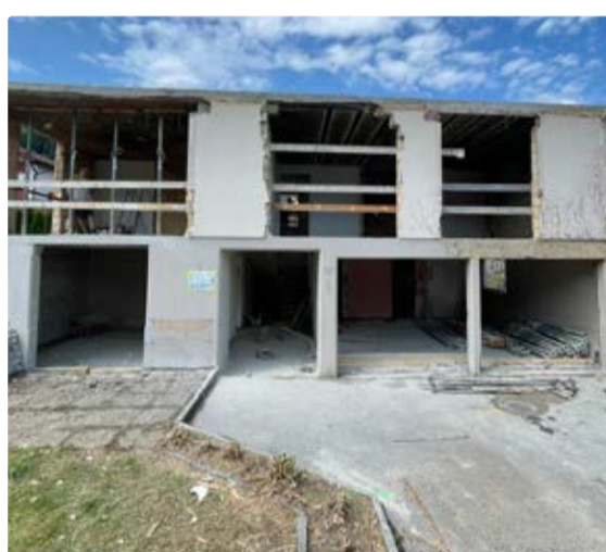
Beim Gebäude (Rohbau) werden die Decken verstärkt und mit An- und Aufbauten versehen.
