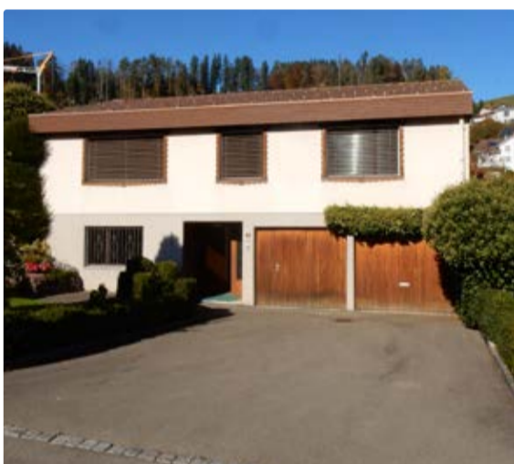
Das Einfamilienhaus in Mosnang wurde in den 1970er Jahren gebaut, einfach und günstig.
