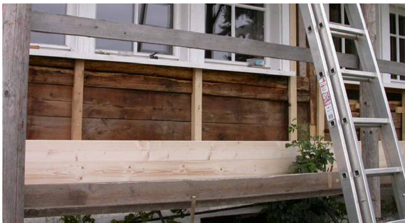
Die Dämmung der Aussenwände ist eine Schlüsselmassnahme bei der energetischen Sanierung von bestehenden Gebäuden.
