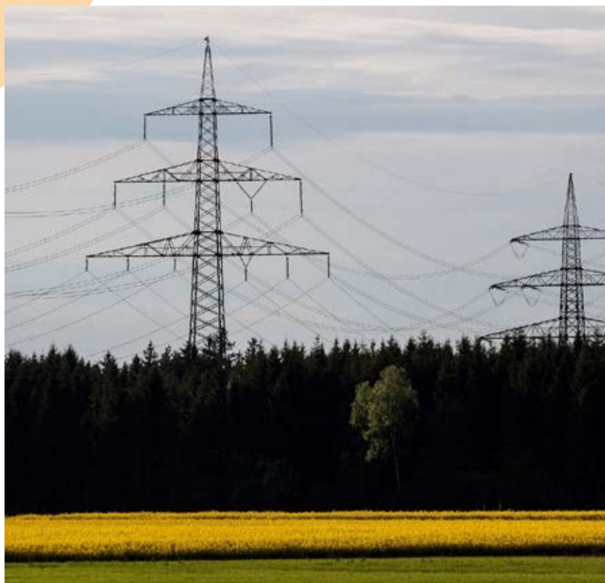
Das Stromgesetz schafft Grundlagen, um in der Schweiz rasch mehr Strom aus erneuerbaren Quellen zu produzieren.
