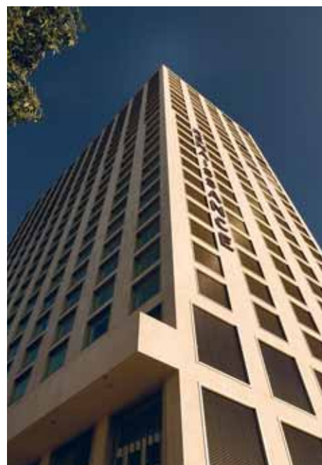
Abbildung 43: Mobimo Tower in Zürich – Vorhangfassade mit Lochfassadenoptik.
