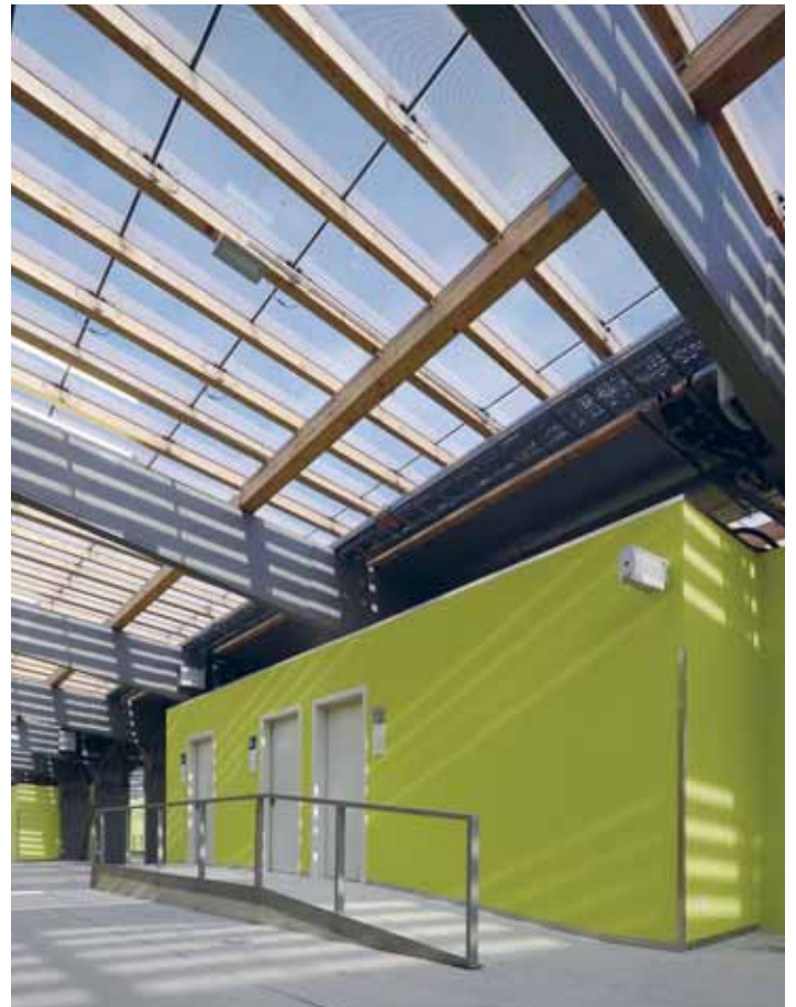
Abbildung 105: Berufsschule in Wolfhagen (Deutschland), Überdachung mit ASI-THRU-Module (Schott) mit integriertem Sonnenschutz. Deutscher Solarpreis 2011. Quelle: HHS Planer + Architekten AG
