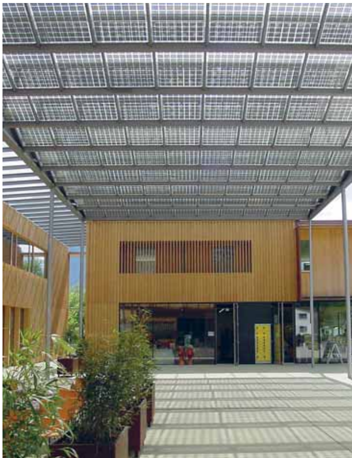
Abbildung 104: Vorplatzbeschattung mit PV-Modulen, Gemeindezentrum Ludesch, Österreich. Quelle: Ertex Solar, Amstetten, Österreich
