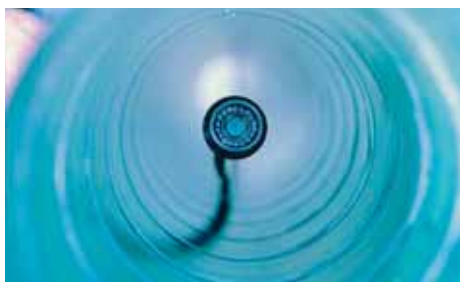
Abbildung 52: IR-Kamera und Druckluft-Reinigungskopf im Einsatz.
