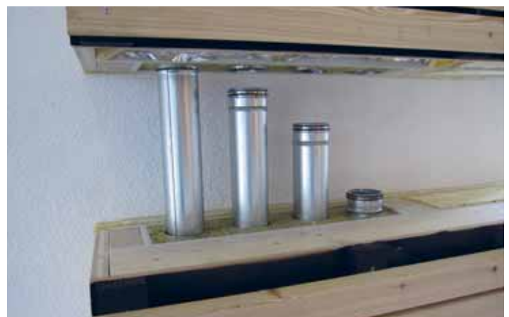
Abbildung 63: Fassadenelemente mit Luftleitungen. Quelle: Projekt CCEM [4]
