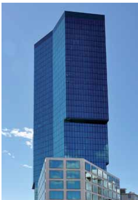
Abbildung 42: Prime Tower in Zürich mit einer vollverglasten Vorhangfassade.
