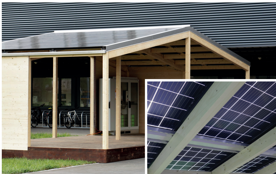
Der Solarpavillon: Eine mobile Photovoltaikanlage produziert vor Ort erneuerbare Energie und bietet Schutz vor Witterungseinflüssen.
