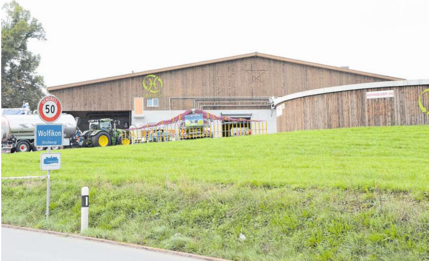
Die Biogasanlage in Wolfikon ist die erste dieser Grössenordnung im Toggenburg.
