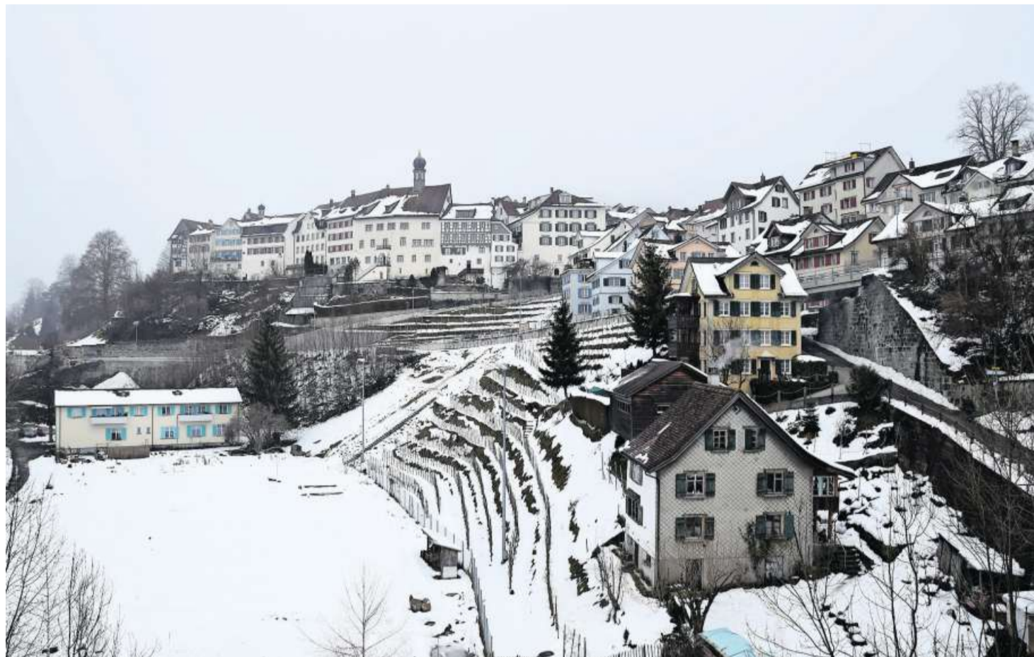
Das Städtli Lichtensteig geht das Projekt Wärmeverbund erneut an.
