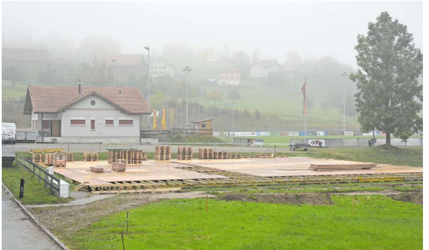
Die Aufbauarbeiten für den Winterzauber sind seit einigen Tagen in Gang.
