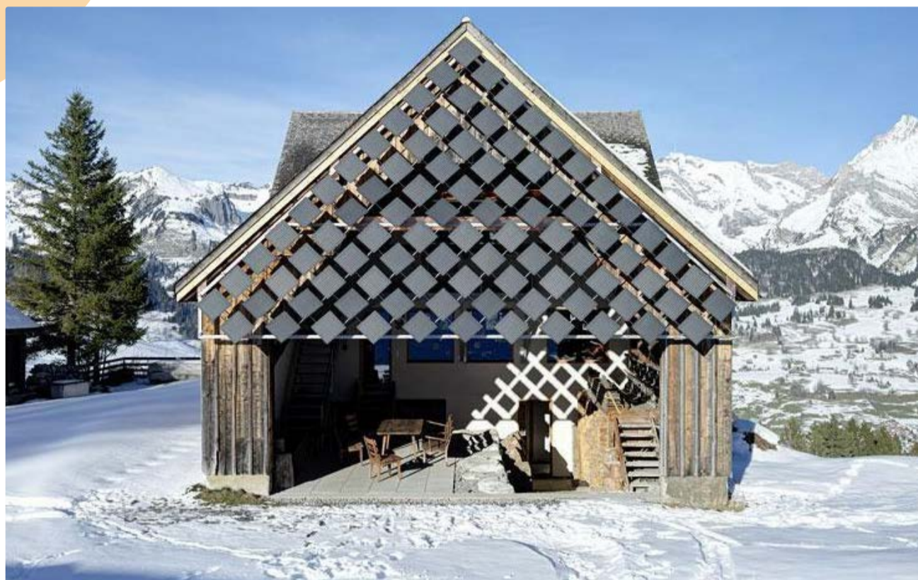
Die Solaranlage an der Südfassade ist robust und effizient, sie passt ausserdem auch optisch zum traditionellen Toggenburger Haus.
