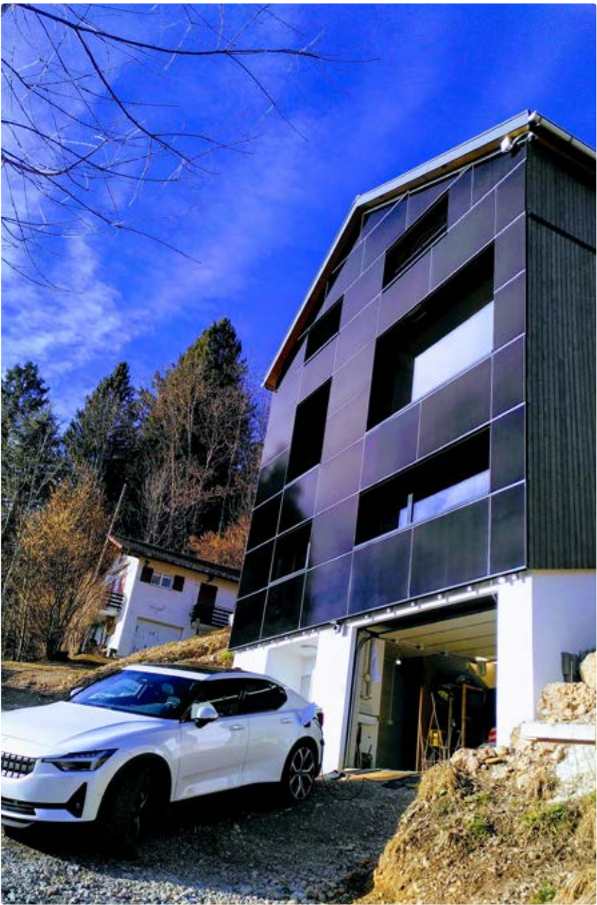
Wenn die Sonne im Winter aufgrund des Winkels kaum aufs Dach scheint, produzieren die Panels an der Fassade genügend Energie fürs Haus und fürs Auto.
